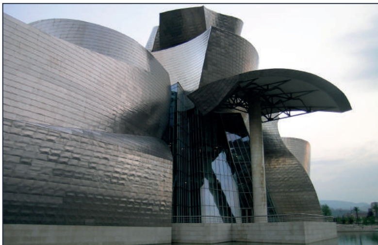
FIGURA 3.6. Frank O. Gehry (1997) Edificio del Museo Guggenheim de Bilbao . Fotografía de R. Marín Viadel, desde el lado que da a la ría.
